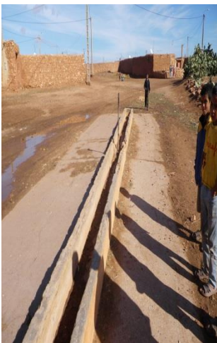
Canal d'alimentation de l'eau pour le bétail
