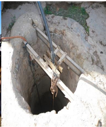
Creusage du puits
